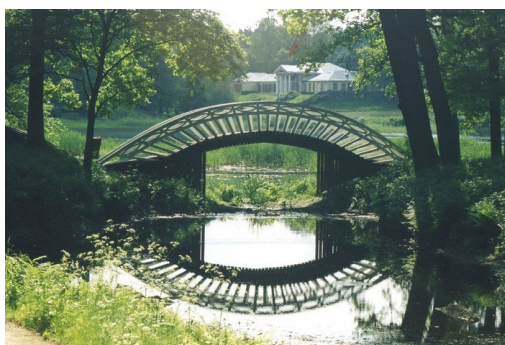
Китайский мостик. Реконструкция 1998 г. Фотоснимок В.А.Позднякова.
